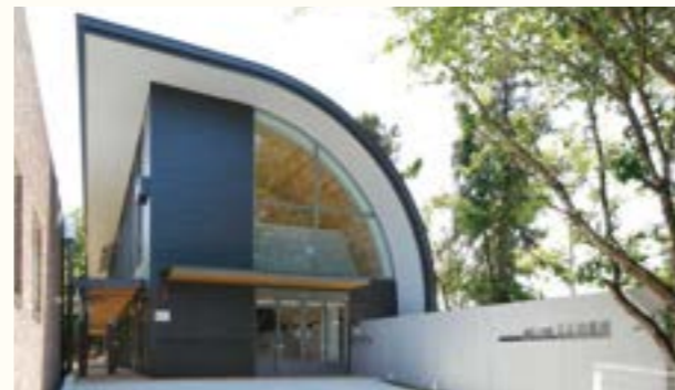
立正幼稚園認定こども園棟 / 設計事務所 (株)ツチヤタケシ建築事務所 / 仕様 一文字葺き・カラーガルバリウム鋼板 / 所在地 埼玉県 / 施工会社 (株)ケージーエム
