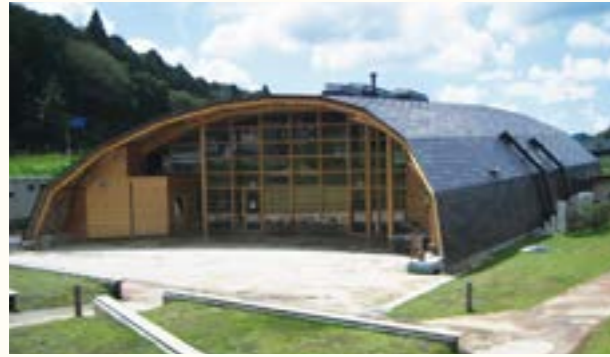
道の駅 もっくる新城 / 設計事務所 (株) 鷗飼哲也事務所 / 仕様 一文字葺き・フッ素ガルバリウム鋼板 / 所在地 愛知県 / 施工会社 三河建設工業 (株)
