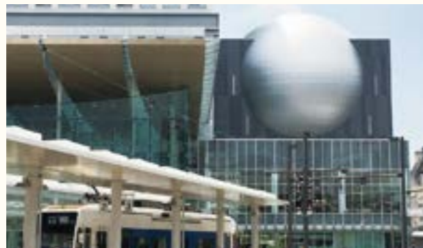
ハピリン(happing) / 設計事務所 (株) アール・アイ・エー / 設計協力 (株) 竹中工務店 / 仕様 一文字葺き・フッ素ガルバリウム鋼板 / 所在地 福井県 / 施工会社 (株) 竹中工務店
