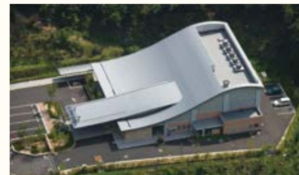
みきやま斎場／設計事務所 三木市役所・(株)黒田建築設計事務所／仕様 一文字葺き・フッ素ガルバリウム鋼板／所在地 兵庫県／施工会社 塩谷運輸建設(株)
