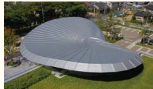
ほんぼーと中央図書館 / 設計事務所 (株)岡田新一設計事務所 / 仕様 一文字葺き・堅平葺き・フッ素ステンレス / 所在地 新潟県 / 施工会社 鹿島・東急・丸運・新潟藤田 JV
