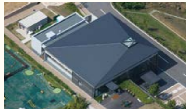
北摂池田メモリアルパーク／設計事務所 (株)喜多隼紀建築事務所／仕様 一文字葺き・カラーガルバリウム鋼板・カラスステンレス／所在地 大阪府／施工会社 (株)竹中土木
