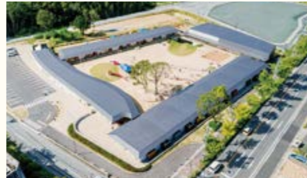
加東みらいこども園 / 設計事務所 (株)シーラクスアンドアソシエイツ / 仕様 一文字葺き・カラーガルバリウム鋼板 / 所在地 兵庫県 / 施工会社 (株)ソネック
