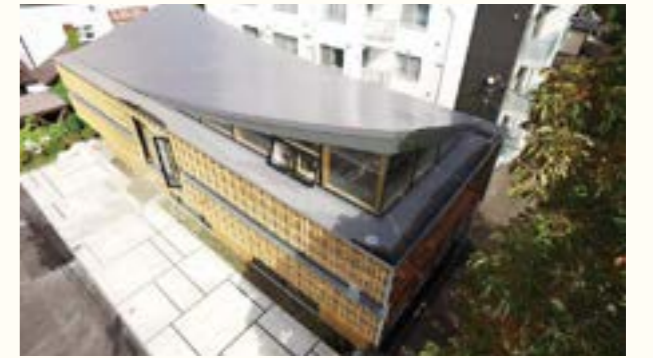
(株)遠藤建築アトリエ新社屋 / 設計事務所 (株)遠藤建築アトリエ / 仕様 一文字葺き・カラスステンレス / 所在地 北海道 / 施工会社 片山鉄建 (株)札幌営業所
