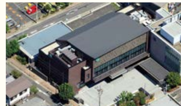
建国寺新本堂／設計事務所 (株)安井建築都市設計事務所／仕様 一文字葺き・亜鉛メッキステンレス／所在地 愛知県／施工会社 (株)竹中工務店
