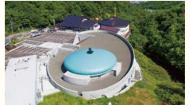
曹洞宗大乗院薬王寺 / 設計事務所 スタジオ・シンフォニカ(有) / 仕様 一文字葺き・カラーガルバリウム鋼板 / 所在地 北海道 / 施工会社 新和建設 (株)
