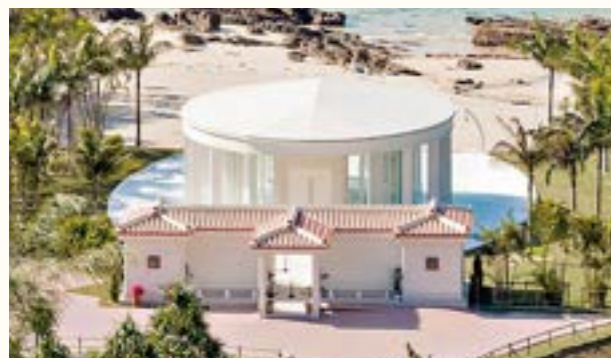
グラン・ブルーチャペル カヌチャベイ(カヌチャリゾート)／設計事務所 (有)ワイズ建築設計室／仕様 一文字葺き・フッ素ガルバリウム鋼板／所在地 沖縄県／施工会社 (株)仲本工業
