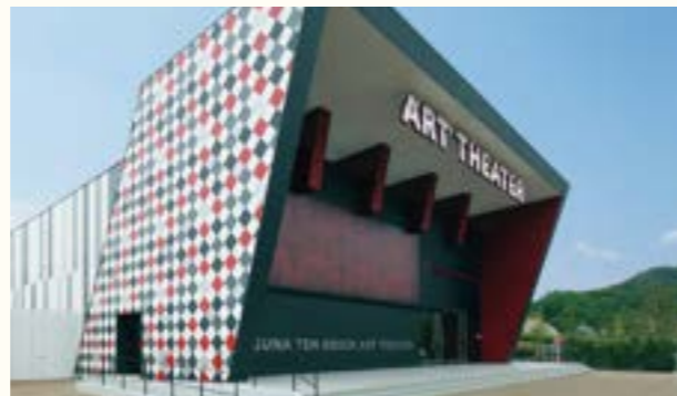
ラゲーナテンボス アートシアター / 設計事務所 市原建築デザイン事務所・(株) H 建築スタジオ / 仕様 菱葺・カラーガルバリウム鋼板 / 所在地 愛知県 / 施工会社 東亜建設工業 (株)
