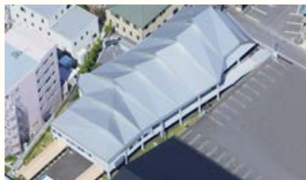
カトリック鈴鹿教会／設計事務所 (株)アルファヴィール一級建築士事務所／仕様 一文字葺き・カラーガルバリウム鋼板／所在地 三重県／施工会社 松井建設(株)
