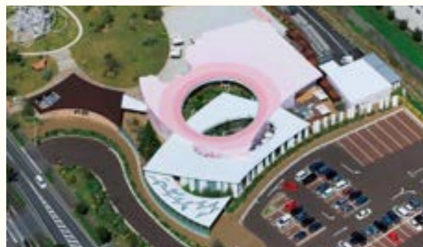
春華堂 niceo(ニコエ)／設計事務所 (株)竹下一級建築士事務所／仕様 一文字葺き・菱葺・カラーガルバリウム鋼板／所在地 静岡県／施工会社 (株)大林組
