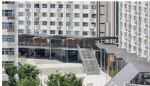
洋光台中央団地広場改修その他工事 / デザイン監修 (株)隈研吾建築都市設計事務所 / 設計事務所 (株)みのべ建築設計事務所 / 仕様 一文字葺き・カラーガルバリウム鋼板 / 所在地 神奈川県 / 施工会社 (株)浅沼組
