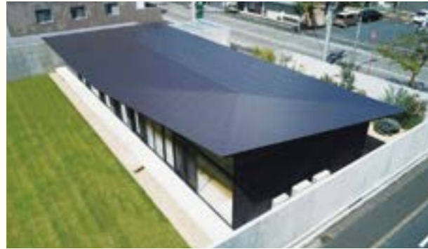
岩国の家 / 設計事務所 SUPPOSE DESIGN OFFICE Co.,Ltd / 仕様 一文字葺き・カラーガルバリウム鋼板 / 所在地 山口県 / 施工会社 (株)カシワバラコーポレーション
