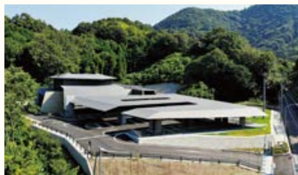
三豊市北部火葬場七宝苑／設計事務所 (株)内藤建築事務所／仕様 一文字葺き・亜鉛メッキステンレス／所在地 香川県／施工会社 (株)菅組
