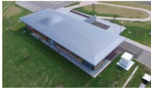
クビド・フェア店舗(レストラン)新築工事 / 設計事務所 (株) NTT ファシリティアズ / 仕様 一文字葺き・カラーガルバリウム鋼板 / 所在地 北海道 / 施工会社 アイグステック (株)
