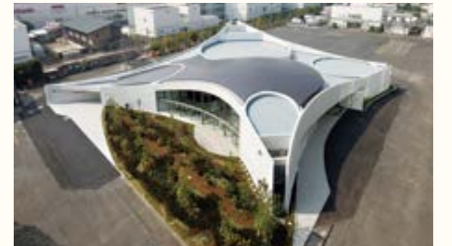
味の素 クライアント・イノベーション・センター / 設計事務所 (株)類設計室 / 仕様 一文字葺き・フッ素ガルバリウム鋼板 / 所在地 神奈川県 / 施工会社 戸田建設 (株)
