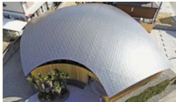
あおぞら保育園 / 設計事務所 (有)ナスカー一級建築士事務所 / 仕様 一文字葺き・フッ素ガルバリウム鋼板 / 所在地 香川県 / 施工会社 富士建設(株)
