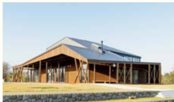
リバーポートパークみのかも／設計事務所 庄野健太郎建築設計事務所／仕様 一文字葺き・フッ素ガルバリウム鋼板／所在地 岐阜県／施工会社 (株)佐合木材
