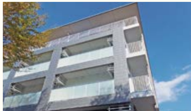
赤羽北さくら荘・赤羽北のぞみ保育園 / 設計事務所 (株)奥野設計 / 仕様 一文字葺き・エルジンク・フッ素ガルバリウム鋼板 / 所在地 東京都 / 施工会社 (株)鴻池組
