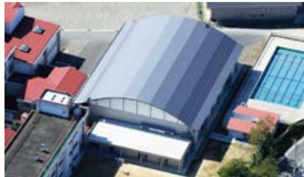
須賀川市立第三中学校屋内運動場 / 設計事務所 (有)保坂陽一郎建築研究所 / 仕様 一文字葺き・フッ素ガルバリウム鋼板 / 所在地 福島県 / 施工会社 (株)横山建設
