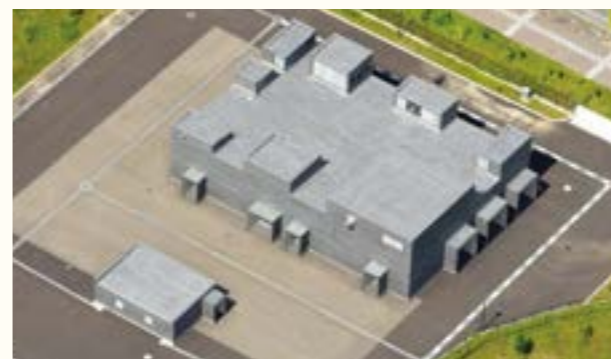
植田受水場／設計事務所 (株)高松伸建築設計事務所／仕様 一文字葺き・亜鉛合金板／所在地 京都府／施工会社 巖・大仙JV
