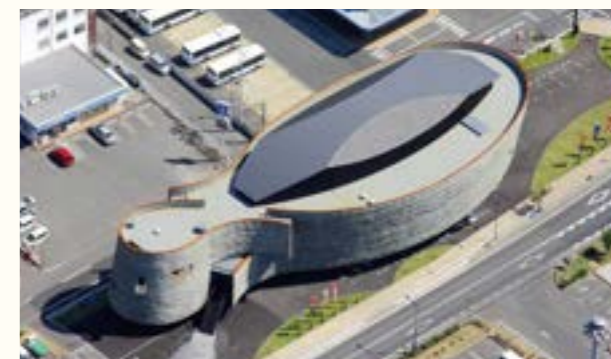
淡路人形座／設計事務所 (株)遠藤秀平建築研究所／仕様 一文字葺き・カラスステンレス／所在地 兵庫県／施工会社 五洋建設(株)
