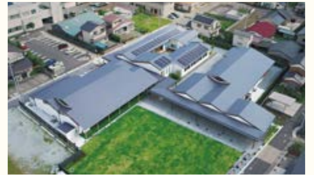
小高区復興拠点施設「小高交流センター」 / 設計事務所 山本堀・URリンクエジ設計共同体 / 仕様 一文字葺き・カラーガルバリウム鋼板 / 所在地 福島県 / 施工会社 (株) 中里工務店
