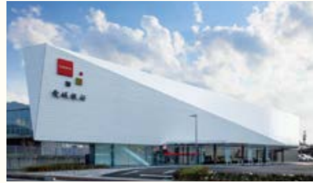
(株) 愛媛銀行 三島支店 / 設計事務所 (株) 日建設計 / 仕様 一文字葺き・フッ素ガルバリウム鋼板 / 所在地 愛媛県 / 施工会社 井原工業 (株)
