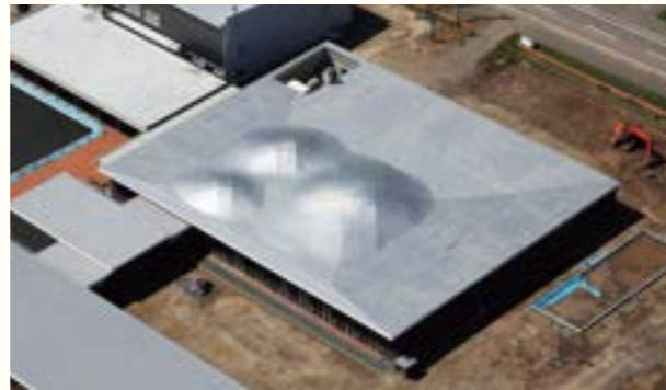
陸別小学校 / 設計事務所 (株)北海道日建設 / 仕様 一文字葺き・フッ素ガルバリウム鋼板 / 所在地 北海道 / 施工会社 荻原・朝倉・佐藤 JV
