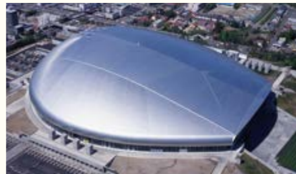
札幌ドーム / 設計事務所 (株) アトリエ・ファイ建築研究所・(株) アトリエブंक 特定共同企業体 / 仕様 一文字葺き・スーパーステンレス / 所在地 北海道 / 施工会社 大成・竹平JV
