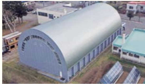
西の里ファミリー体育館 / 設計事務所 (株) 協立建築設計事務所 / 仕様 一文字葺き・フッ素ガルバリウム鋼板 / 所在地 北海道 / 施工会社 玉川・広谷JV
