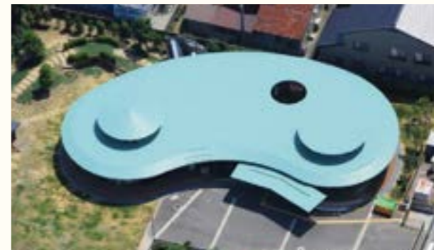
さみどり認定こども園 / 設計事務所 (株)鈴木一級建築士事務所 / 仕様 一文字葺き・カラーガルバリウム鋼板 / 所在地 富山県 / 施工会社 石坂建設(株)
