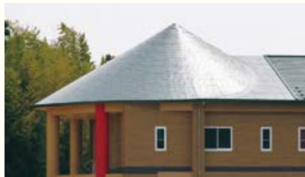
学校法人 中央学園 認定こども園ひま中央こども舎 / 設計事務所 増田建築設計事務所 / 仕様 一文字葺き・カラーガルバリウム鋼板 / 所在地 富山県 / 施工会社 松井建設(株)
