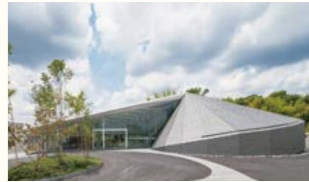
(株)キョウトー本社社屋兼工場 / 設計事務所 (株)bandesign / 仕様 一文字葺き・タフテンZ (亜鉛メッキステンレス) / 所在地 愛知県 / 施工会社 松井建設 (株)
