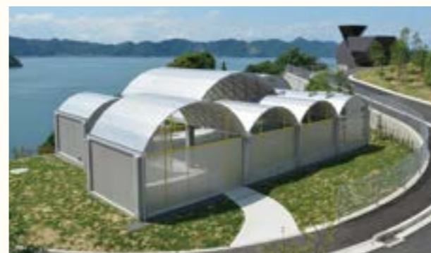
伊東豊雄ミュージアム(シルバーハット)／設計事務所 (株)伊東豊雄建築設計事務所／仕様 一文字葺き・フッ素ガルバリウム鋼板／所在地 愛媛県／施工会社 大成建設(株)
