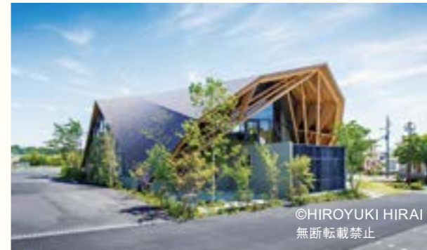
SYNEGIC office / 設計事務所 一級建築士事務所ウエノアトリエ / 仕様 一文字葺き・銅板 / 所在地 宮城県 / 施工会社 八光建設 (株)
