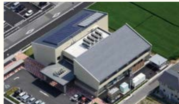
安祥福祉センター / 設計事務所 (株)伊藤建築設計事務所 / 仕様 一文字葺き・カラーガルバリウム鋼板 / 所在地 愛知県 / 施工会社 (株)丸山組
