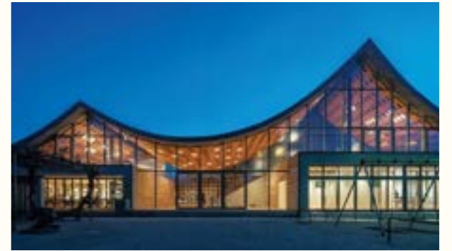
知立の寺子屋 / 設計事務所 (株) マウントフジアーキテツスタジオ一級建築士事務所 / 仕様 一文字葺き・カラーガルバリウム鋼板 / 所在地 愛知県 / 施工会社 小原建設 (株)
