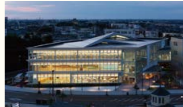
イクネスしばた / 設計事務所 (株)佐藤総合計画 / 仕様 一文字葺き・フッ素ガルバリウム鋼板 / 所在地 新潟県 / 施工会社 加賀田・石井・岩村 JV
