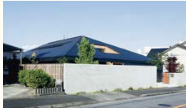
H/h / 設計事務所 (株)和田吉貴建築事務所 / 仕様 一文字葺き・亜鉛メッキステンレス / 所在地 愛知県 / 施工会社 (株)麦島建設
